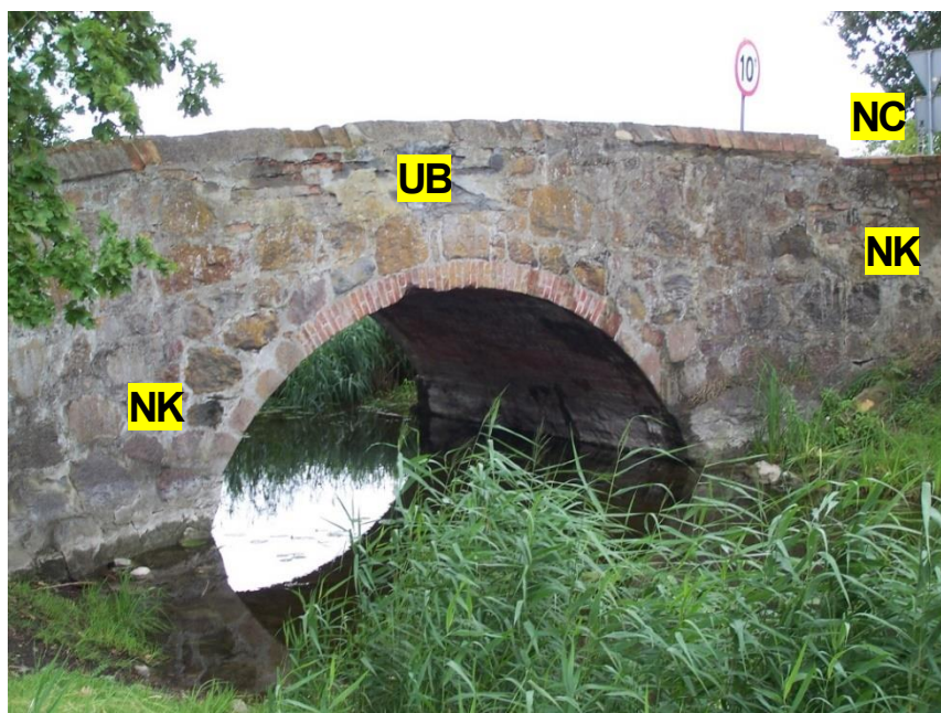
Fot. 5. Widok na elewację wschodnią mostu:
