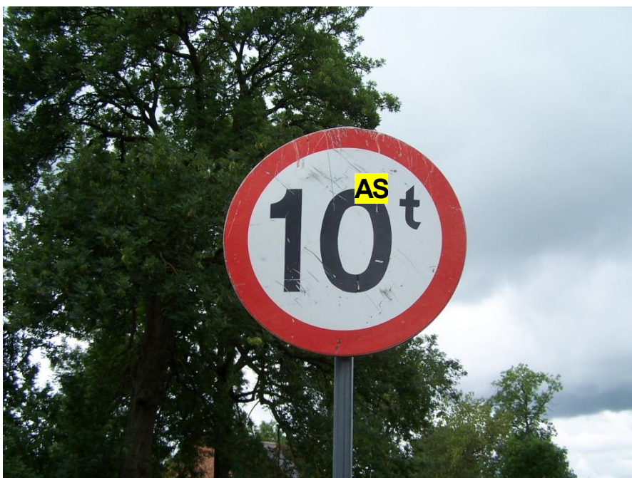
Fot. 4. Porysowana powierzchnia znaku drogowego przez przejeżdżające pojazdy
