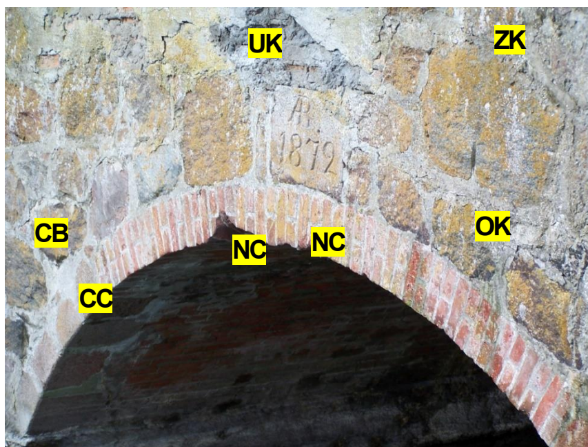
Fot. 6. Szczegół przęsła sklepionego j.w.:
